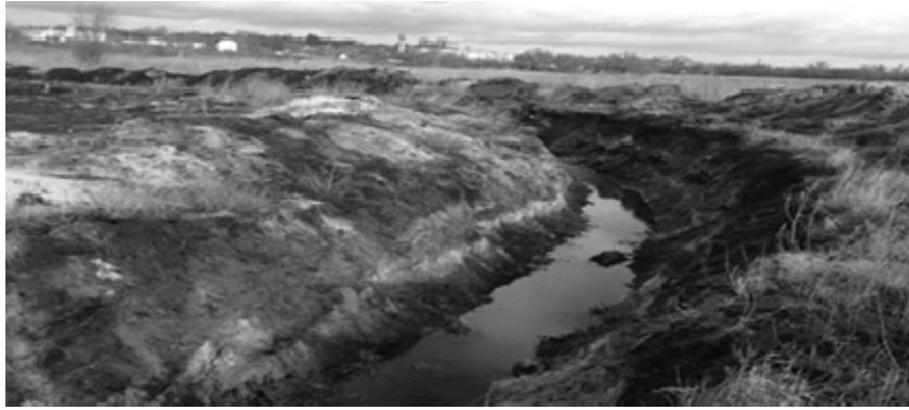
Рис. 26.19. Локализация очагов возгорания торфяников канавами, пойма р. Рокач
