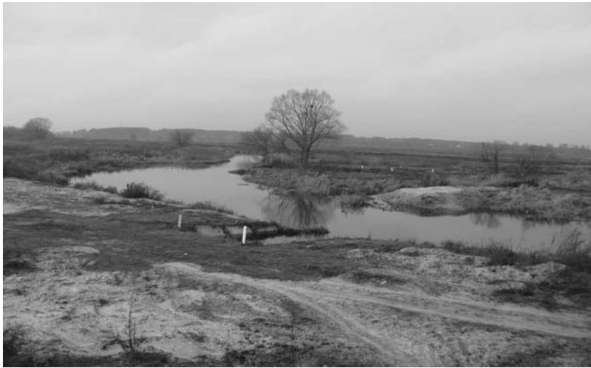
Рис. 26.20. Остатки временной плотины на р. Ирпень (по состоянию на ноябрь 2015 г.)
