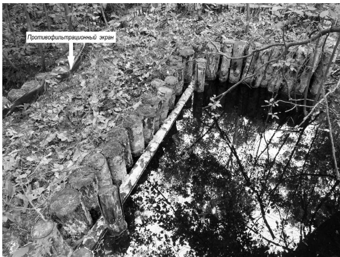
Рис. 25.14. Глухая перемычка со стенками из кольев с загнутыми краями и полиэтиленовым противофильтрационным экраном (фото автора)
