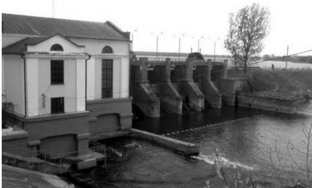
Рис. 30.3. Хринницкая МГЭС на р. Стырь, после реконструкции в 2002 г.
