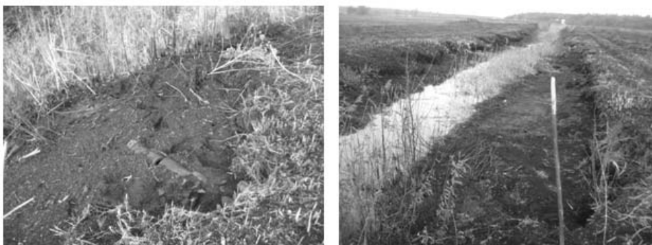
Рис. 26.9. Выгорание торфяных почв на откосах и бровках канала К-72-1 Ирпенской осушительно-увлажнительной системы (по состоянию на 15.11.2015)
