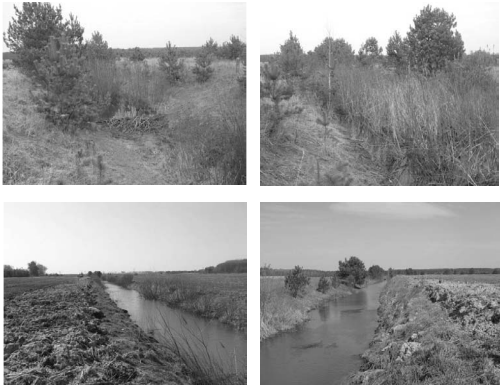
Рис. 29.8. Состояние осушительного канала 1-Др до и после очистки
