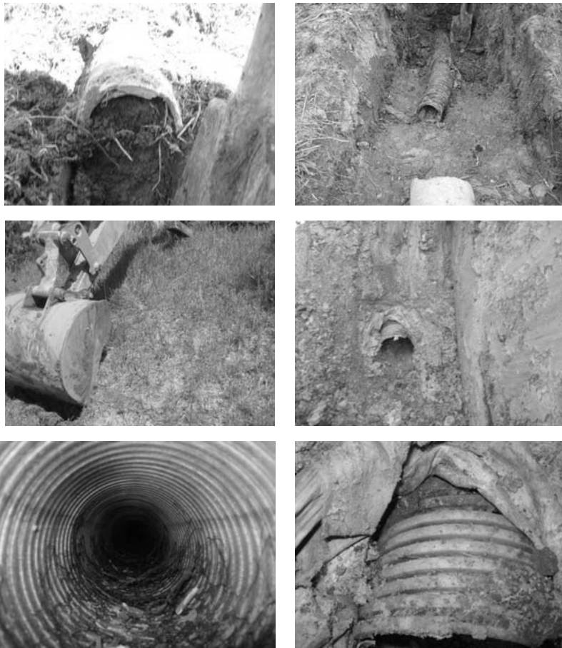
Рис. 29.6. Техническое состояние устьев закрытого горизонтального дренажа
