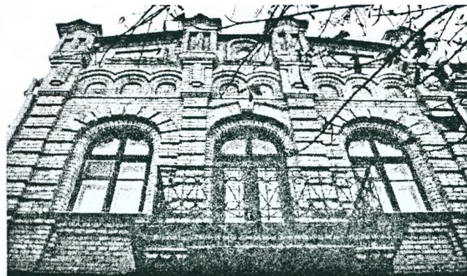
Рисунок 7 – Жилой дом по ул.К.Маркса №11 (Медовая). Стилизация элементов в романском стиле: пилоны с завершением башенками, высокий арочный фриз. Реставрация 2007 года
