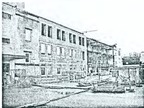
Фото № 3 – Вид здания АБК после выполнения кирпичной кладки первой захватки
