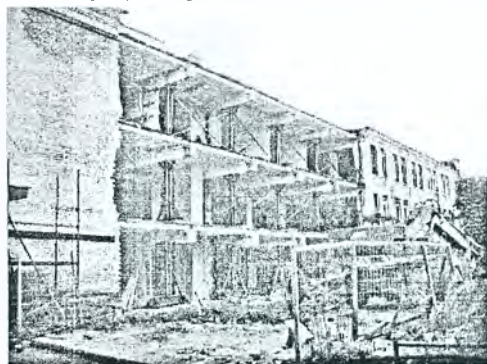
Фото № 2 – Вид здания АБК при демонтаже кирпичной стены первой захватки
