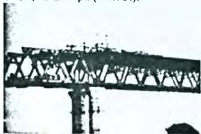
Рисунок 3 – Монтаж пролета 8-9 «в навес»
