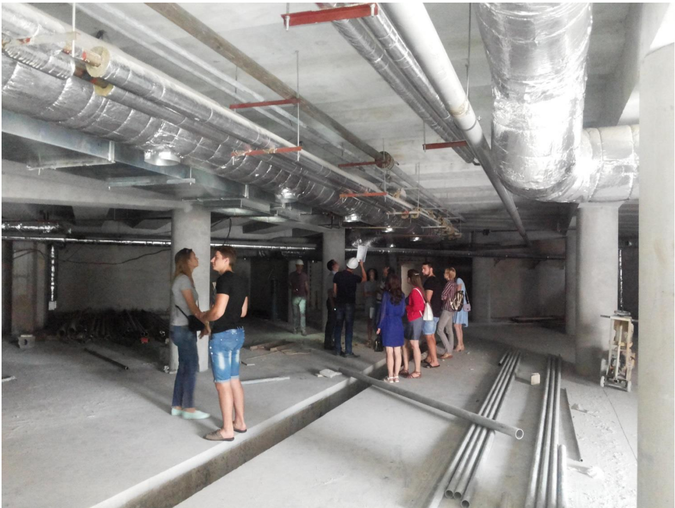
Рисунок 12 – Студенты на экскурсии на строящемся объекте
