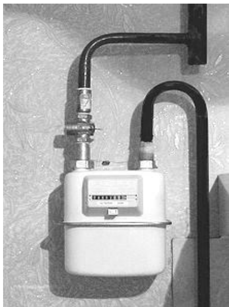
Рис. 6.1. Бытовой мембранный счетчик типа Г – 6: 1 — корпус; 2 — крышка; 3 — измерительный механизм; 4 — кривошипно-рычажный механизм; 5 — верхние клапаны газораспределительного устройства; 6 — стяжная полоса
