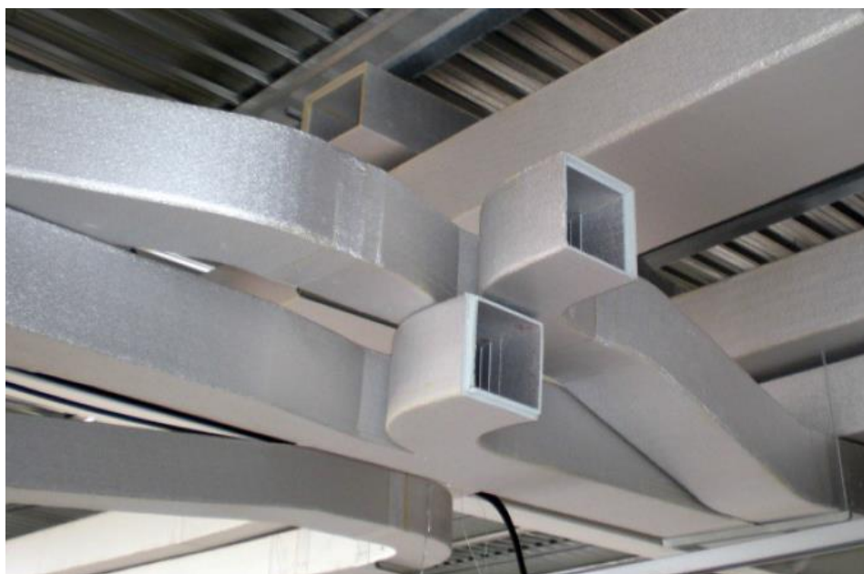
Рисунок 10.8 – Воздуховоды из PIR-панелей
