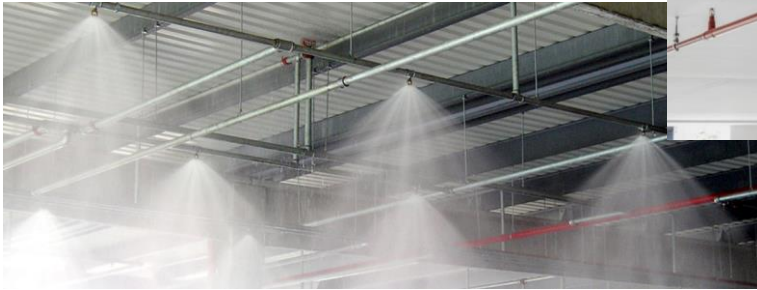
Трубопроводы со спринклерами
