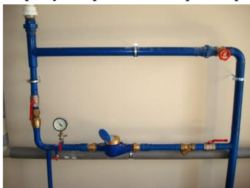
Гидравлическая схема водомерного узла
