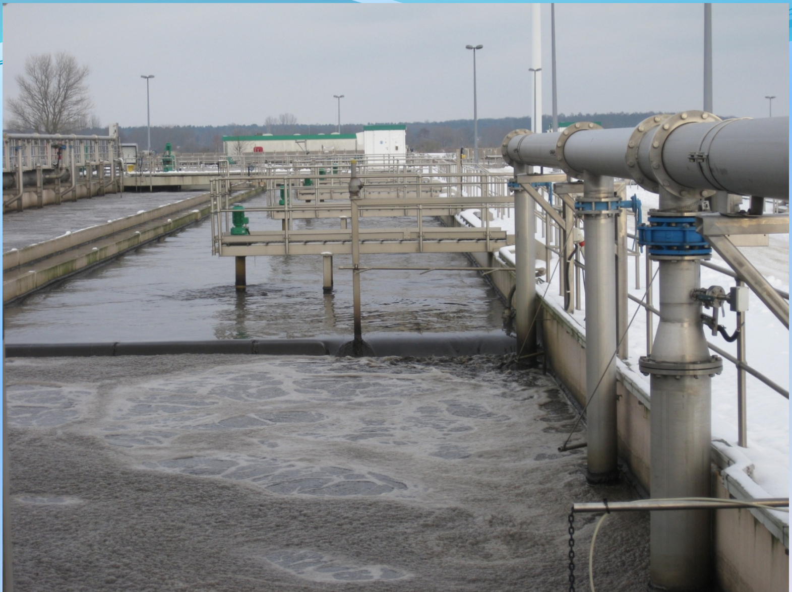
Рисунок 9 – Аэротенк станция «Шёнерлинде» г. Берлина
