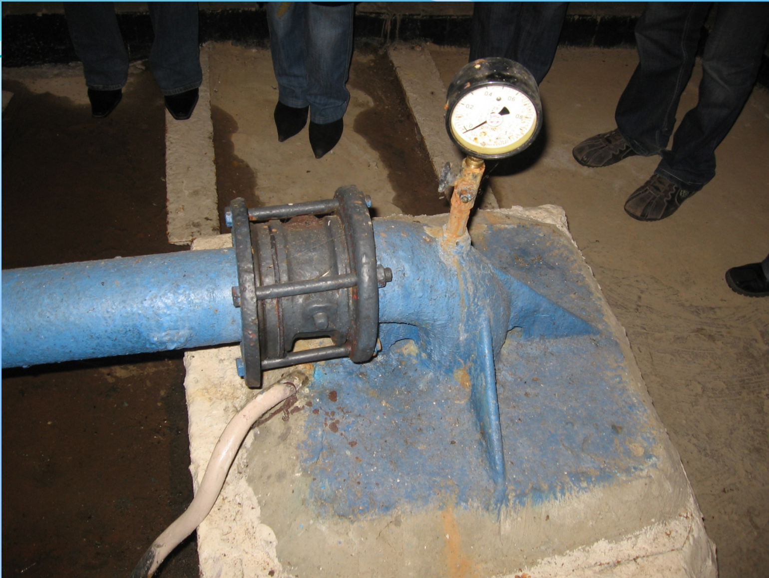
Рисунок 6 - Оголовок скважины
