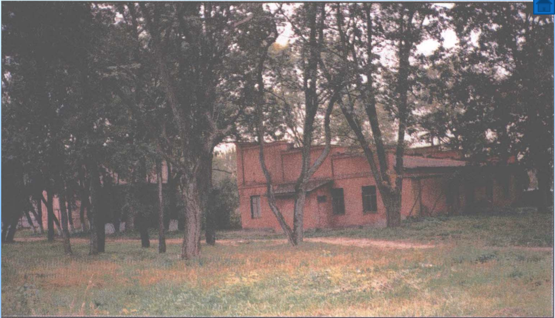
Рисунок 3 - Первая насосная станция городского водопровода
