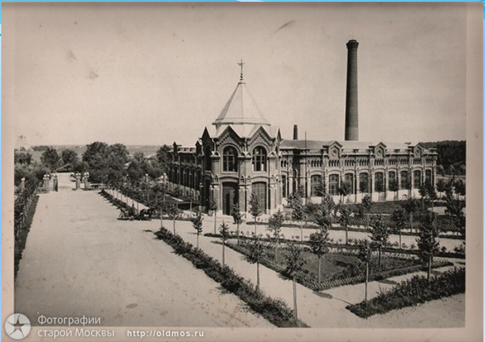
Рисунок 7 - Алексеевская насосная станция
