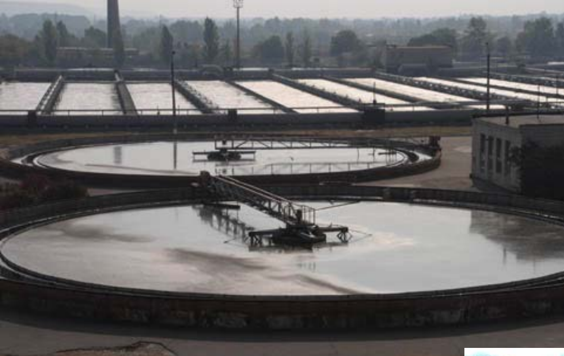
Рисунок 5 - Первичные радиальные отстойники. Общий вид двух отстойников
