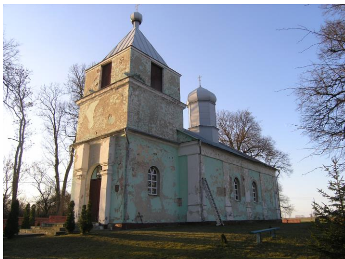
Рисунок 4 – Церковь в д. Сычи до реставрации
