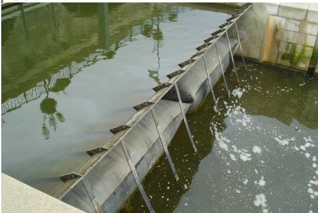
Затвор Обермейера во Франции на реке Соне
