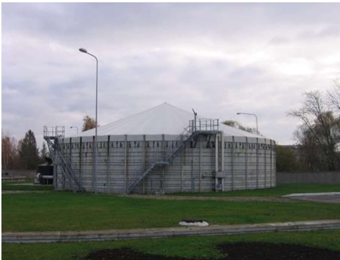
Рисунок 1 – Перекрытие анаэробной ёмкости биологической очистки тканевым перекрытием (Очистные сооружения г. Даугавпилс)
