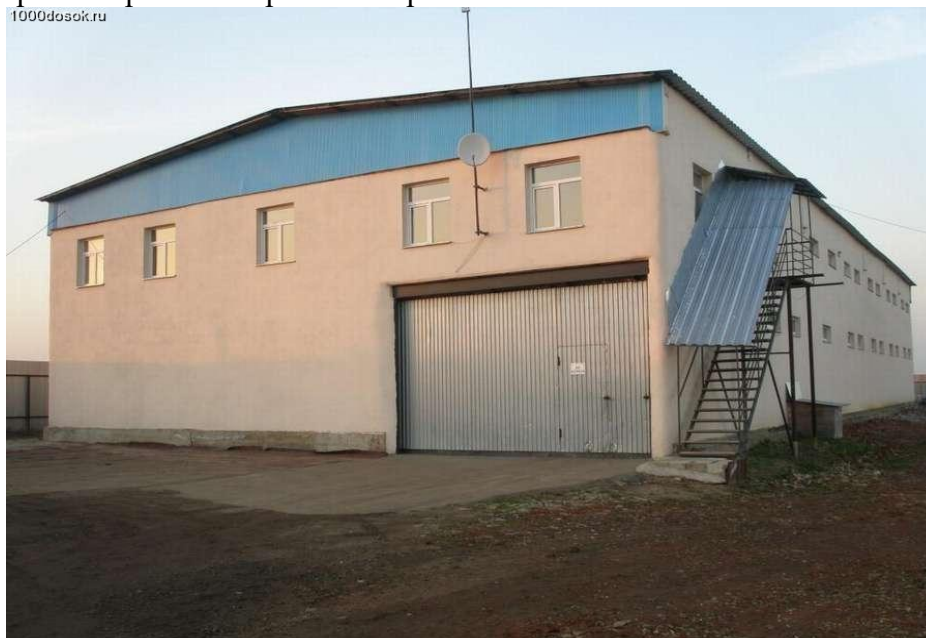
Рисунок 7 – Склад общего пользования
