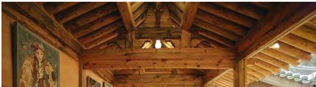
Рисунок 6 – Деревянные конструкции, поддерживающие свес крыши «чхома»
