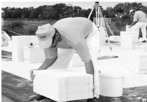
Рисунок 3 – Укладка углового блока первого ряда
