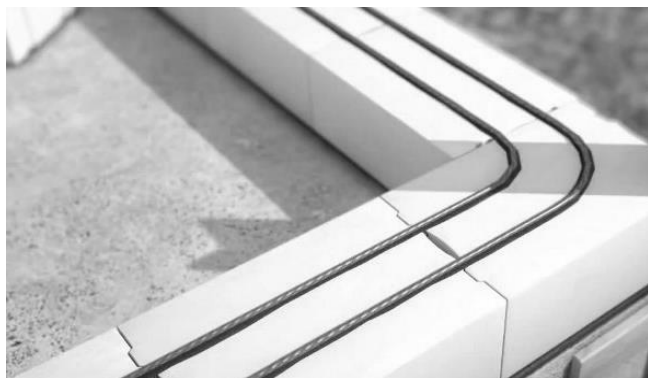
Рисунок 5 – Нарезка штроб под арматуру и уложенная арматура
