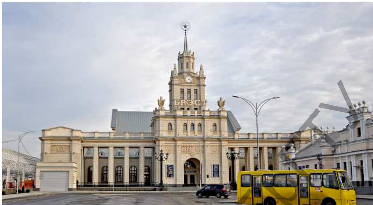
Рисунок 3 – Здание вокзала после реконструкции
