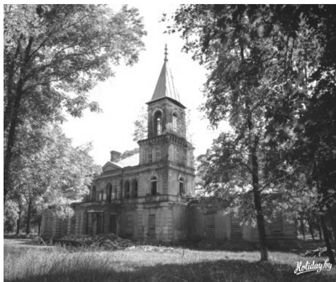
Рисунок 6 – Вид на боковой фасад
