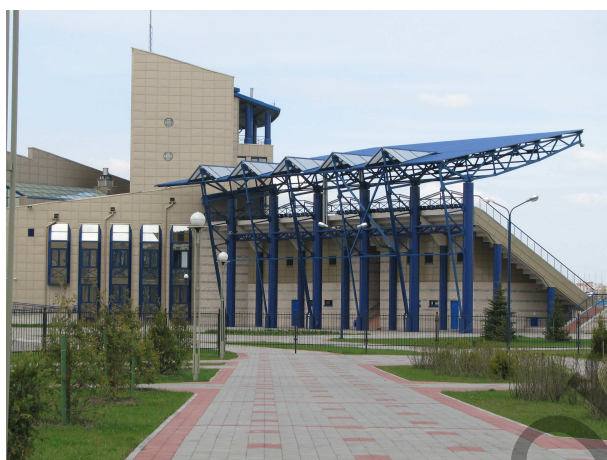
Рисунок 6 – Козырёк над зрительной трибуной Гребного канала
