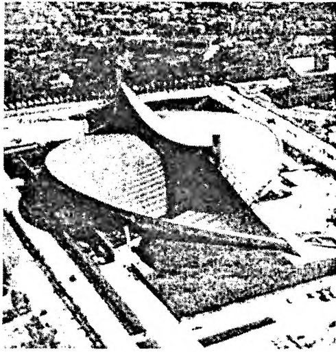
Рис.17. Тектоника висячих систем. Токио. Олимпийский плавательный бассейн: общий вид и интерьер. Арх К. Танге, инж. Е. Цубои
