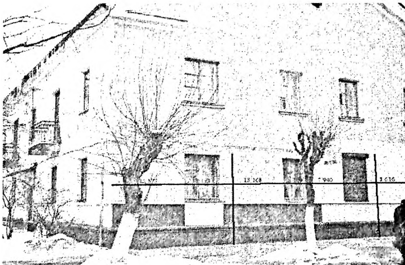
Рисунок 2. Места измерений при выполнении обмерных работ
