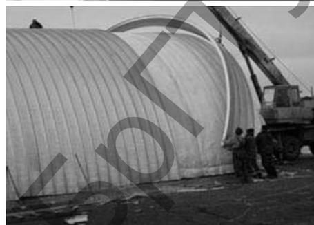
**Рис. 4.** Фрагменты монтажа арочного здания, возводимого по бескаркасной технологии
