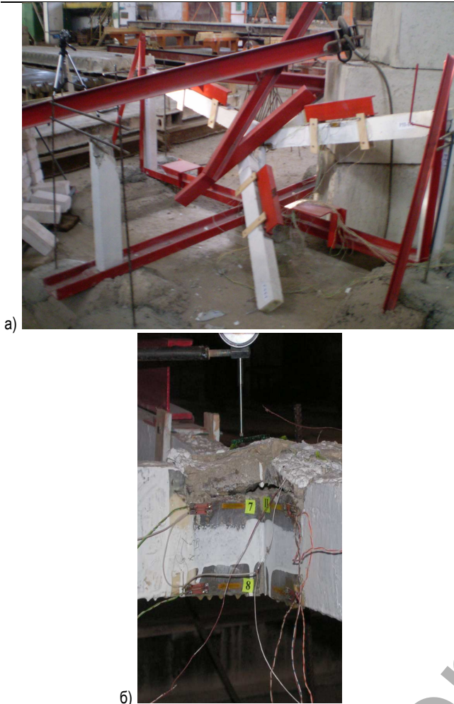
Рис. 3. Общий вид разрушения фрагмента первой (а) и второй серий (б)
