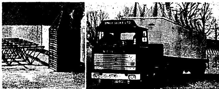
Рис. 3. Схемы компактной упаковки пирамид при складировании (а) и перевозке (б)
