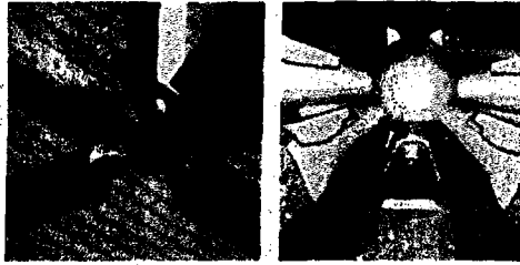
Рис. 5. Пример дерево-металлической структуры типа «Меро»
