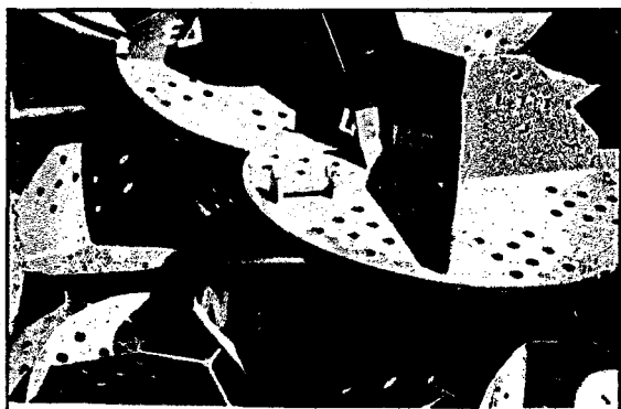
Рис. 8. Узлы на пространственных листовых фасонках
