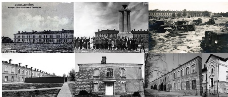
Илл. 2. Фотографии Северного городка г. Бреста, в котором была расквартирована 50-й гвардейская стрелковая дивизия: казарма 19 саперного батальона русской императорской армии, то же место – праздник в честь приезда в городок маршала Пилсудского, далее – место расквартирования советских танковых батальонов в 1939-1941 гг., последние три фото в коллаже – нынешний вид построек городка.
