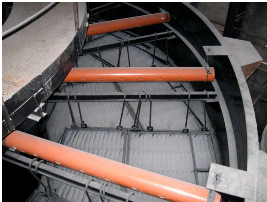
Тонкослойные сотоблоки в вертикальном отстойнике со встроенной КХО
