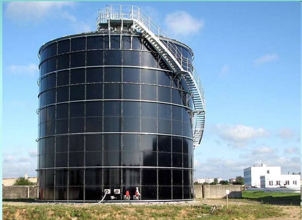
Возведённый биогазовый реактор (метантенк) на очистных сооружениях в г.Барановичи
