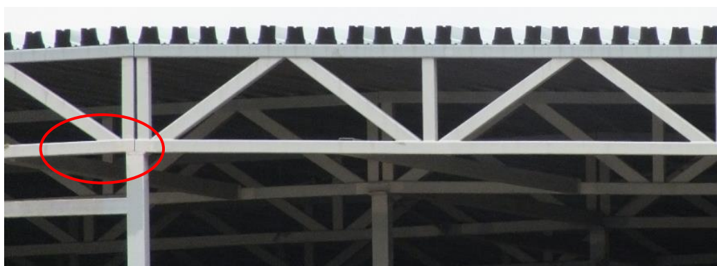
Рисунок 2 – Применение нетипового опорного узла фермы
