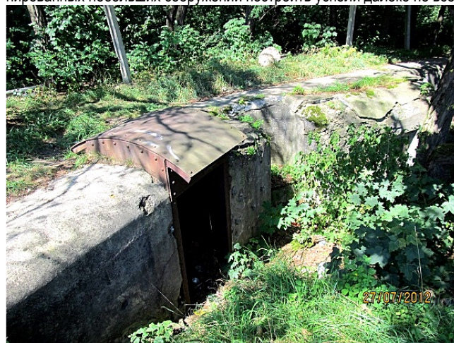
Фото 2. Наблюдательный пост на форту Б, вписанный в бетонный бруствер
