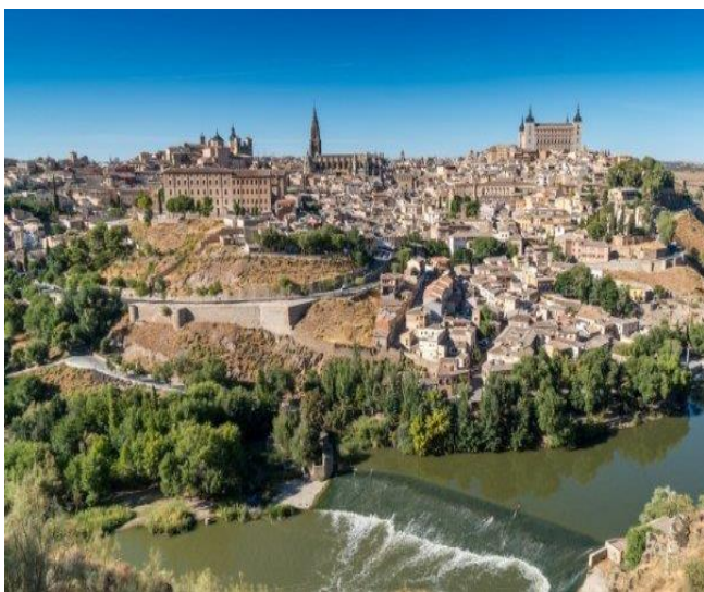
Испания, г. Толедо, р. Тохо, переливная плотина
