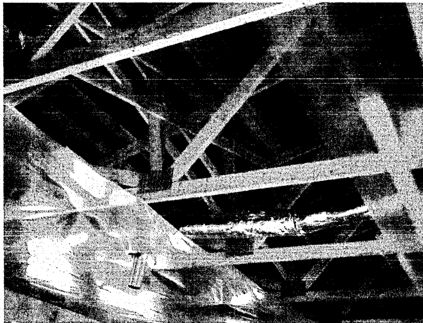
Рисунок 5 – Деревянные фермы покрытия
