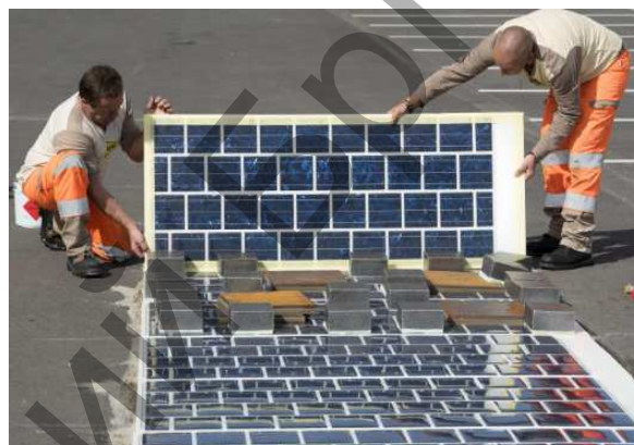
Рисунок 4, 5 – Дорожное покрытие плиты Wattway
