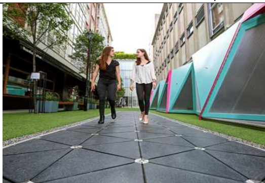
Рисунок 10, 11 – Пластины тротуара, преобразующие энергию шагов пешехода в электричество
