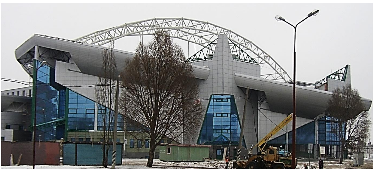
Рисунок 1 – Общий вид покрытия дворца для игровых видов спорта «Виктория» в г. Бресте
