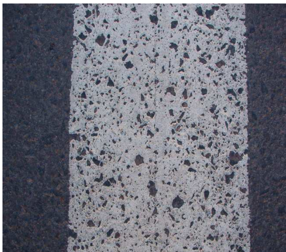
Рис. 3. Фотография разметки (полимер №1) после 4 месяцев натуральных испытаний (износ 15–20%)
