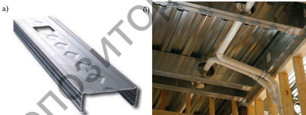
Рисунок 2 – Усовершенствования в геометрии СТП: а) несущий профиль с ребрами и выштамповками; б) несущая балка из спаренных С-профилей фирмы Metwood, Inc.
