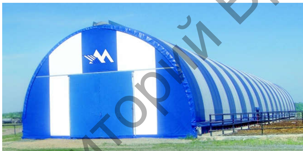
Рисунок 1 – Общий вид каркасно-тентового арочного здания фирмы Милена-АГРО
