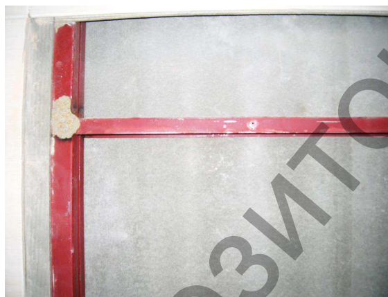
Рис. 3. Фрагмент участка вскрытия обшивки перегородки
