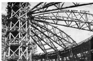
**Рисунок 8 – Монтаж ферм купола**
