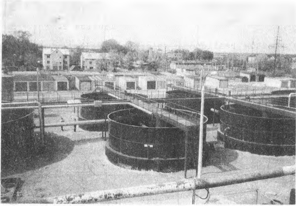
Rys.2. Zbiorniki wtórne typu 2810 na oczyszczalni ścieków w Grajewie
