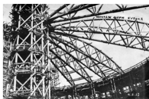
Рисунок 8 – Монтаж ферм купола
