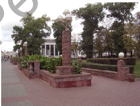
Рисунок 4 – Ограда из бетонных блоков по ул. Энгельса
