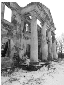
Рисунок 1 – Современный вид портика северного фасада усадьбы Гребницких со стороны входа
