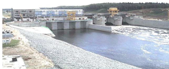
Рисунок 2 – Витебская ГЭС (вид с нижнего бьефа) (фото автора)
