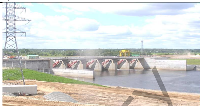
Рисунок 4 – Полоцкая ГЭС (вид с нижнего бьефа)
