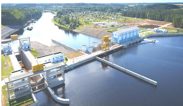
Рисунок 3 – Витебская ГЭС (вид с верхнего бьефа)
