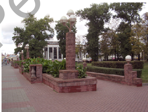
Рисунок 4 – Ограда из бетонных блоков по ул. Энгельса
