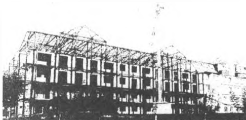
Рисунок 1 – реновация здания по ул. Осипенко, 19, г. Минск
