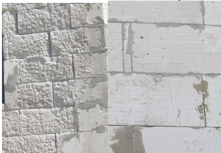
Рисунок 3. Вид наружных поверхностей ячеистобетонных изделий одинаковых декларируемых характеристик различных производителей. (Изделия находились в аналогичных условиях эксплуатации одного населённого пункта)
