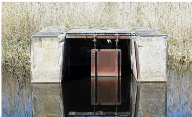
*Плотина Пуаре* представляет собой защищенный от размыва лоток прямоугольного сечения, ограниченный флютбетом и боковыми стенками и оборудованный металлическими поворотными фермами, на которых фиксируются щиты (или спицы), обеспечивающие поддержание требуемого напора. Конструкция плотины была предложена
