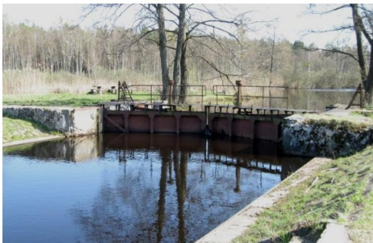
занимать любое положение в пределах уровня в ВБ и до уровня воды в НБ. Основными элементами шлюза являются головы (верхняя и нижняя), камера и подходы к шлюзу. В головах шлюза, выполненных из монолитного бетона, располагается механическое оборудование – ворота и механизмы управления ими. Они могут открываться и закрываться для пропуска судов
