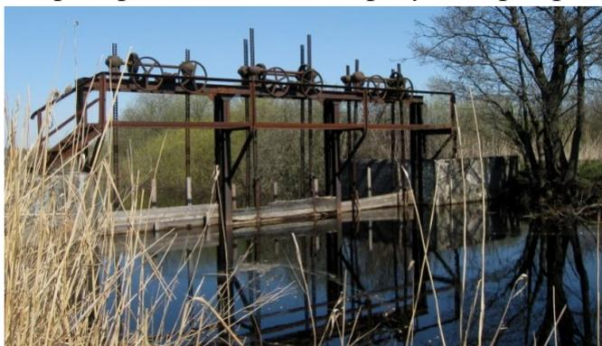
сечения шириной 10,15 м, защищенный от размыва флютбетом и сопряженный с берегами с помощью береговых устоев. Основным элементом флютбета является водобойная часть длиной 4,5 м, выполненная из монолитного железобетона. В пределах ширины водобоя размещены три пазовые рамы шириной 3,38 м каждая. Регулирование уровней воды на
