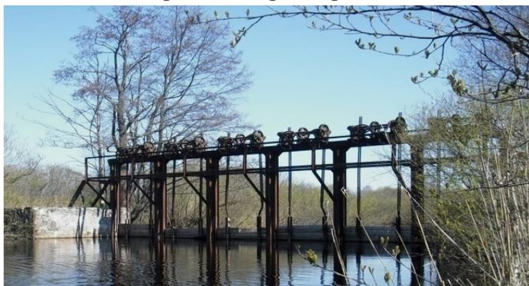
ного железобетона. В пределах ширины водобоя размещено шесть пазовых рам шириной каждая по 2,5 м. Регулирование уровней воды на каждом пролете осуществляется вручную с помощью подъемных механизмов, состоящих из двух цевочных реек с зацепами деревянных щитов и редуктора. Для маневрирования затворами со стороны верхнего бьефа предусмотрен служебный мостик с перильным ограждением из профильных уголков и лестницы, для подъема на мостик с правого и левого береговых устоев.
