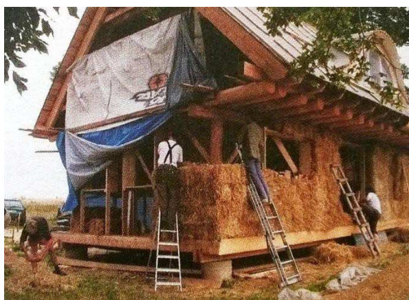
Рисунок 1 – Технология возведения каркасного дома из соломенных блоков
