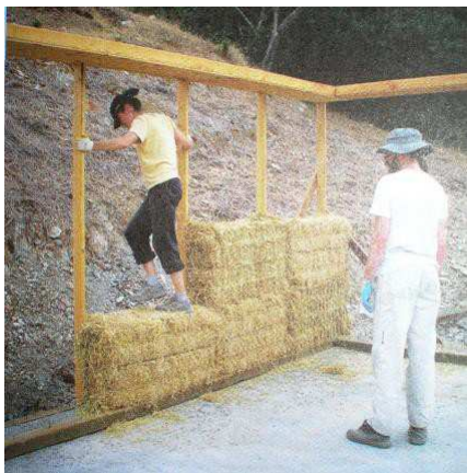
Рисунок 1 – Технология возведения каркасного дома из соломенных блоков
