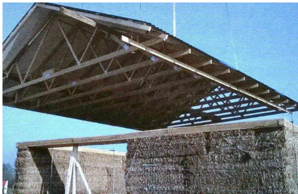
Рисунок 2 – Технология возведения бескаркасного дома из соломенных блоков
