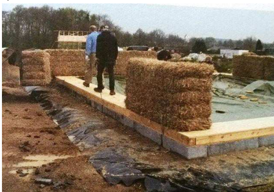
Рисунок 2 – Технология возведения бескаркасного дома из соломенных блоков
