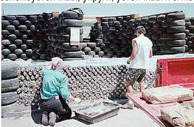
Рисунок 1 – Возведение стен и перегородок из шин
