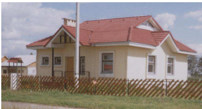
Рис. 9. Трехкомнатный жилой дом в населенном пункте Бардин Гомельского района (с внутренним тамбуром).
