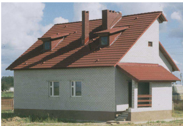
Рис. 10. Трехкомнатный жилой дом в населенном пункте Рудковщина Горецкого района (с внешним тамбуром).
