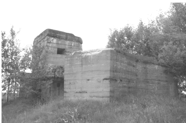
Фото 7 – Одно из сохранившихся сооружений (Ляховичский р-н)
