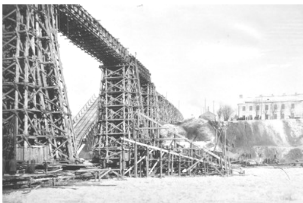
Фото 1 – Строительство моста в Гродно
